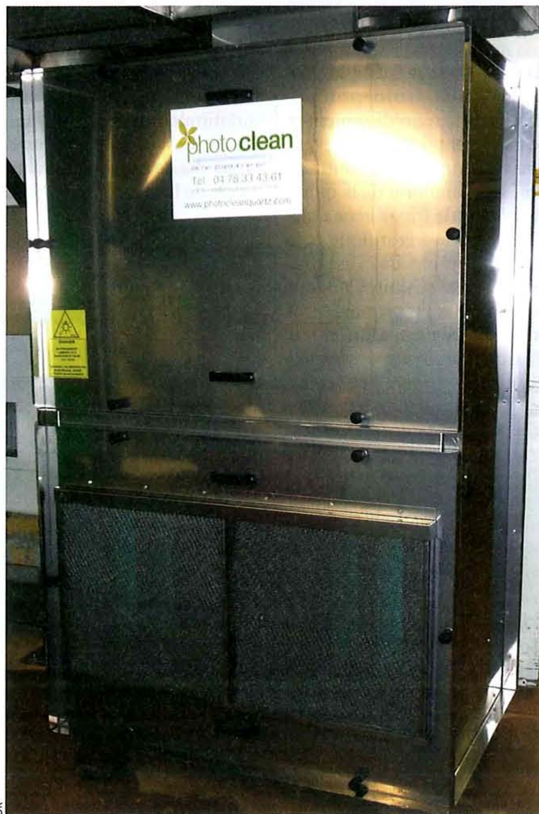
Ce caisson inox de traitement et de surpression d'air permet le contrôle de la contamination microbologique et accélère le séchage de la pièce lors du lavage grâce à l'arrivée d'air neuf purifié.
