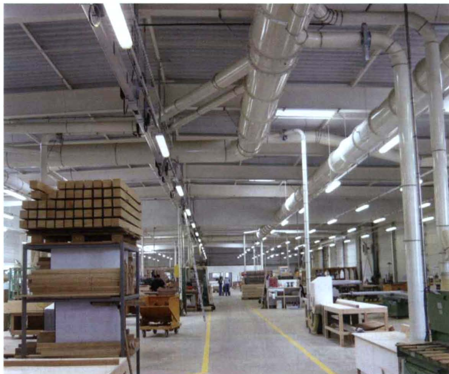
Le processus d'aspiration distingue deux réseaux dans l'atelier pour améliorer l'efficacité globale du process.
