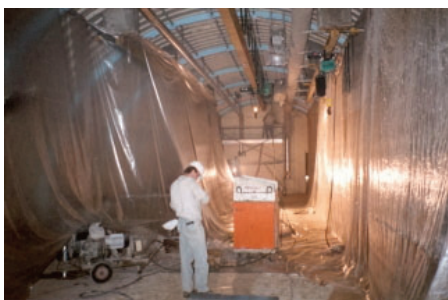
Le démantèlement se fait dans une enceinte sous dépression.
